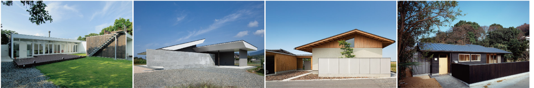
使用写真/設計:井内清志/森裕/吉武研二/進藤勝之 撮影:森武史/小川重雄/石井紀久/鈴木研一
